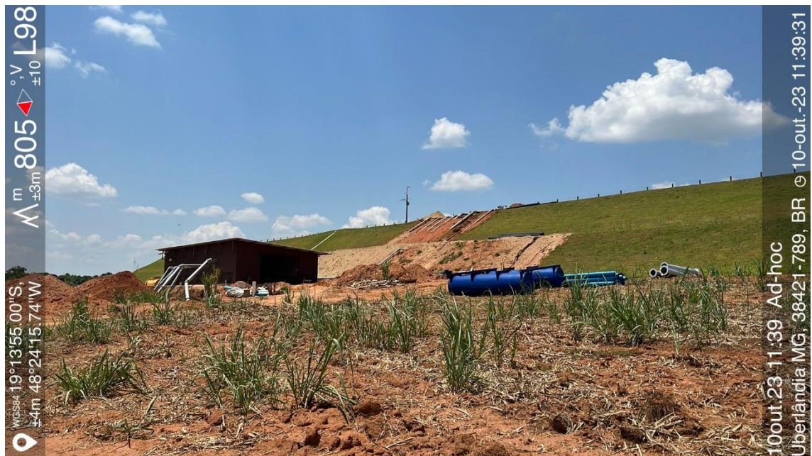
Figura 7.15 Casa de bombas do piscinão
