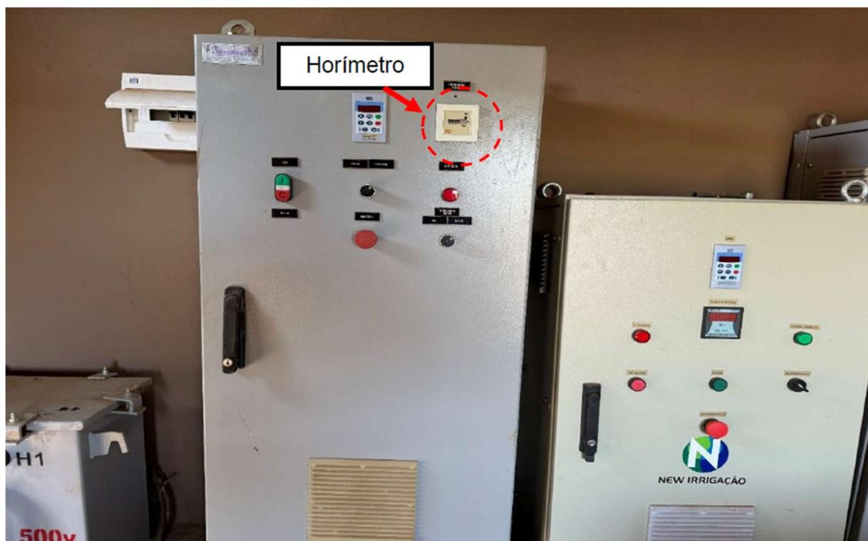
Figura 8.5: Horímetro instalado no painel de controle.
