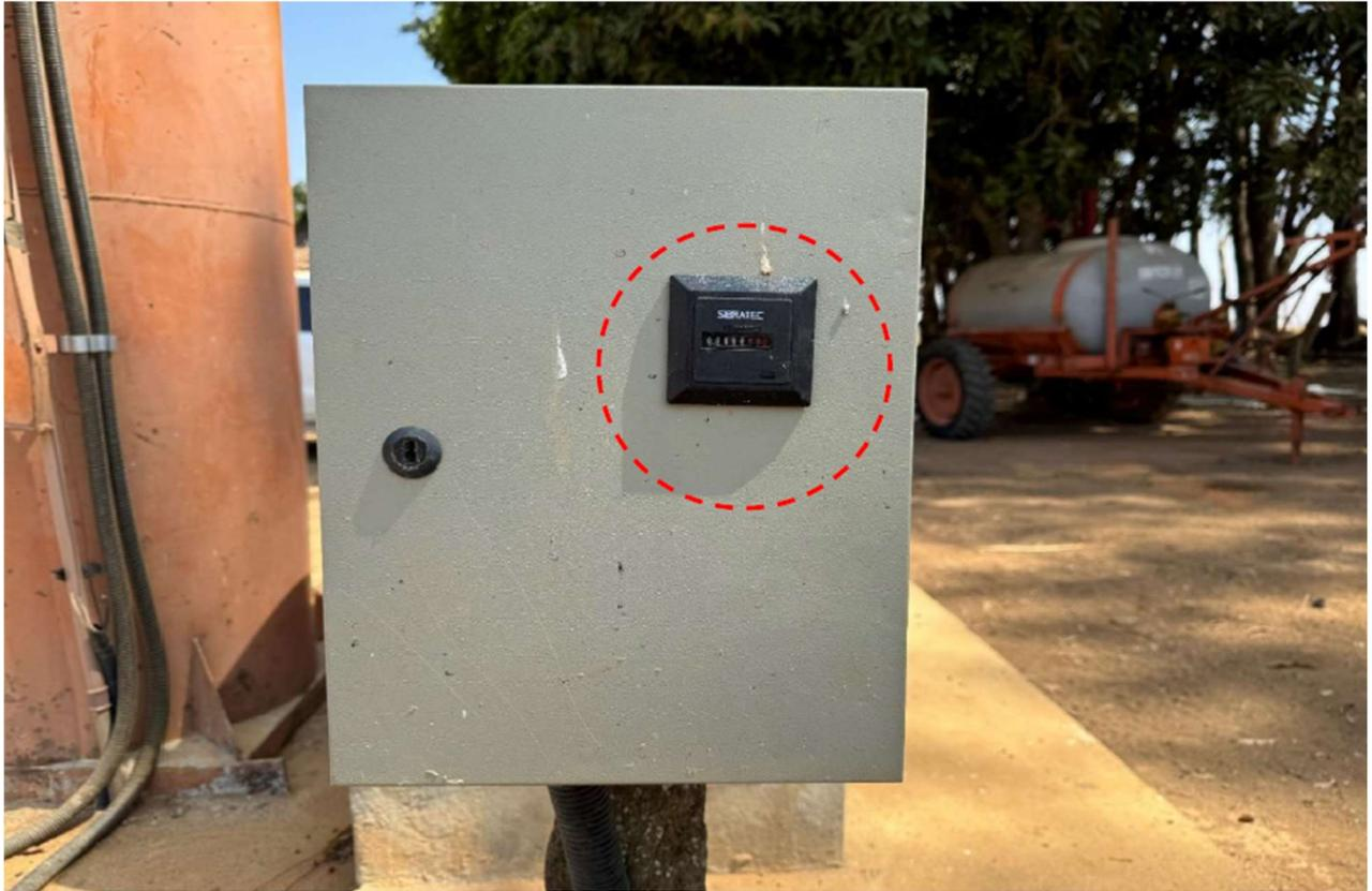
Figura 8.3: Horímetro instalado no painel de controle.
