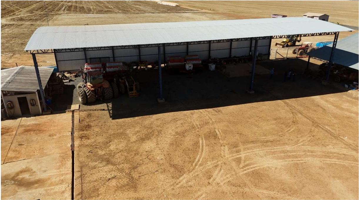
**Figura 5.3:** Galpão de guarda de maquinários na Fazenda 3F, contendo brita no solo como medida provisória.
