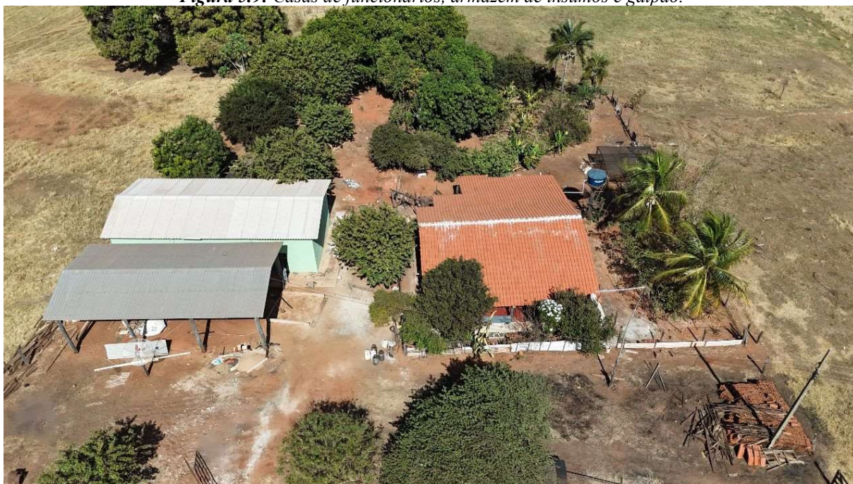
Figura 5.9: Casas de funcionários, armazém de insumos e galpão.
