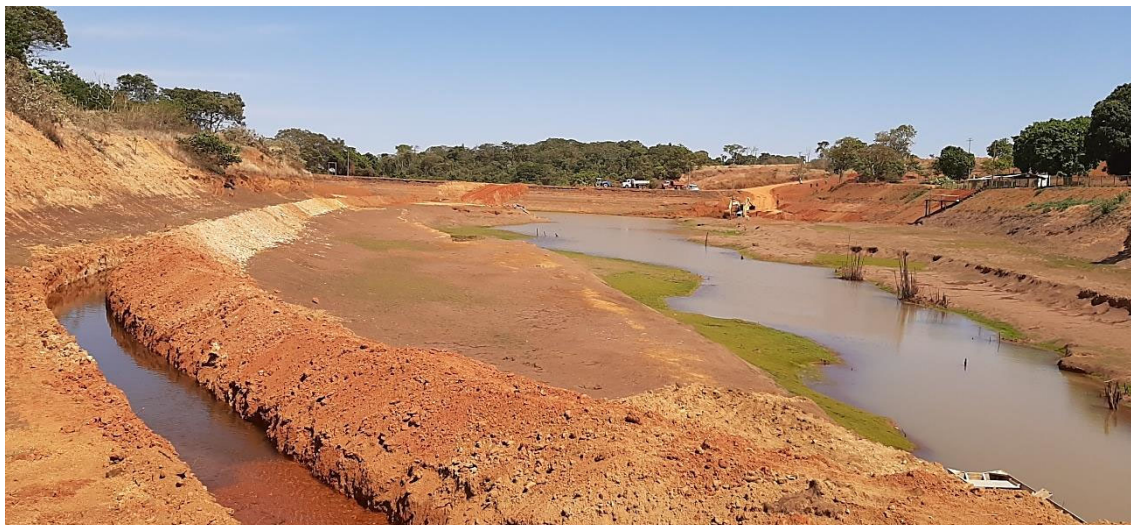
Figura 8.4-5 – Barramento para captação em curso de água, com regularização de vazão (área máx. menor ou igual 5,00 ha). Na ocasião da visita de campo este barramento se encontrava em reforma visando à adequação do aterro e dos vertedouros (serviço, emergência e de fundo).
