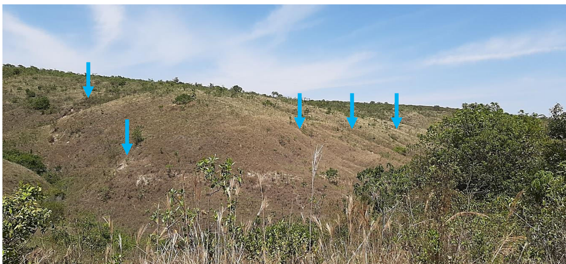
Figura 6.4.2-3 – Intenso ravinamento nas vertentes fluviais, indicado por setas, produzido pelas águas pluviais que escoam sobre a superfície do terreno.
