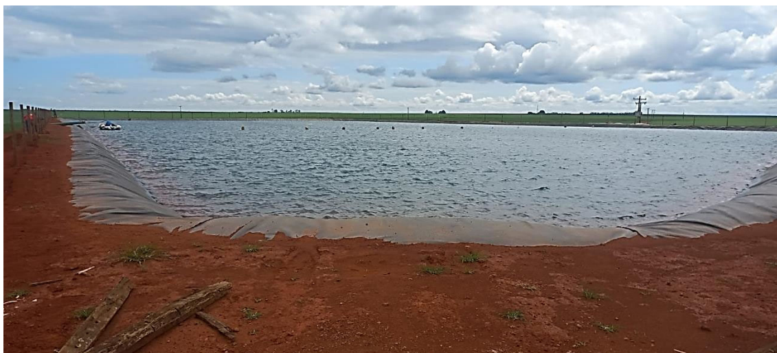
Figura 8.4-6 – Tanque parcialmente escavado no solo (piscinão) e revestido com geomembrana de PEAD destinado ao armazenamento de água captada em barramento localizado na ADA do empreendimento.
