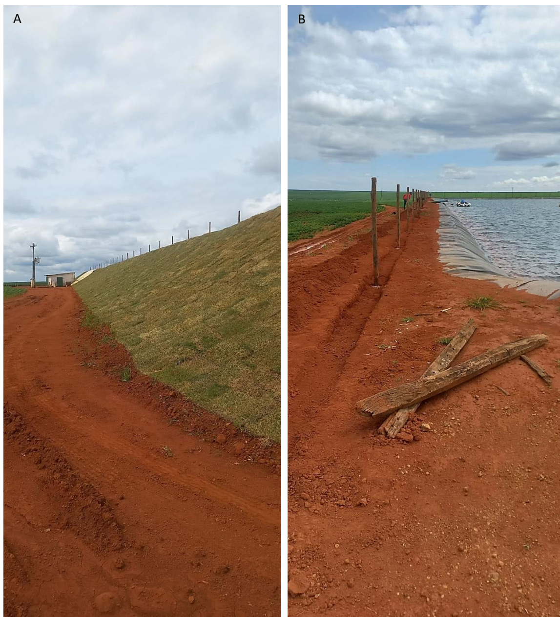
Figura 8.4-7 - Na ocasião dos levantamentos de campo esta estrutura se encontrava em obras com vistas à proteção do aterro contra erosão com plantio de placas de grama (A) e cercamento do perímetro (B).
