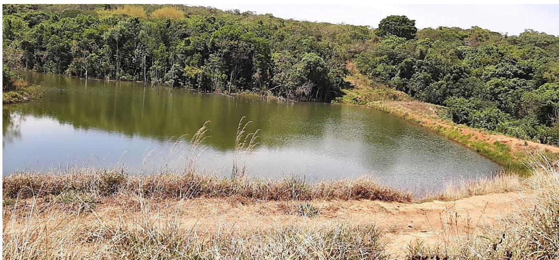
Figura 8.4-4 – Barramento para captação de água e regularização de vazão em afluente da margem esquerda do córrego Fernandes.
