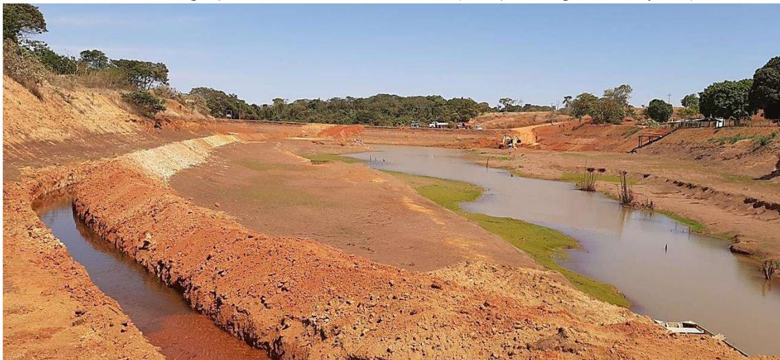
A Figura 8.4-6 mostra uma estrutura destinada ao armazenamento de água em reservatório (piscinão) na ADA do empreendimento. Trata-se de um tanque parcialmente escavado no solo e complementado em altura por aterro compactado e internamente revestido com geomembrana de PEAD.
