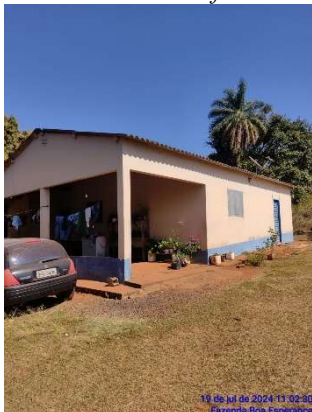
Figura 11.33: Casa de funcionários.
