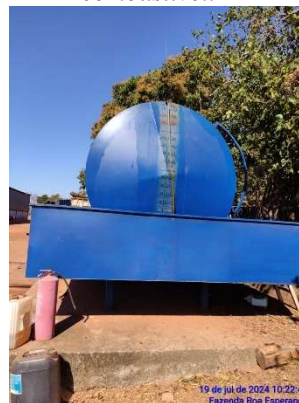
Figura 11.32: Posto de abastecimento de combustível.
