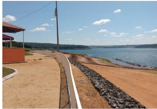
Figura 11.22: Balneário Social de Nova Ponte.
