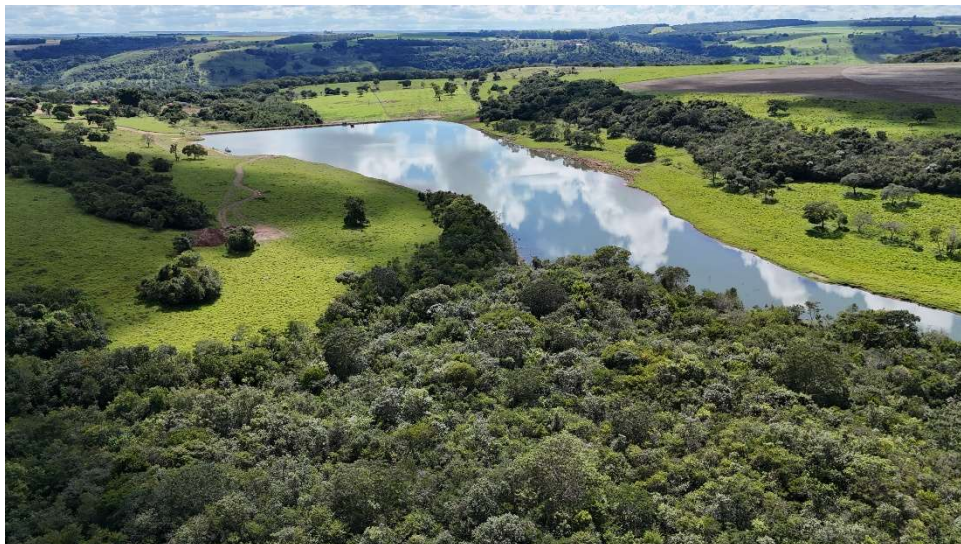
Figura 36 - Barramento para captação de água com regularização de vazão na ADA do empreendimento
